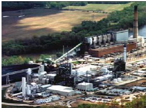
Figure 1.4 : Usine de gazéification du charbon [27]
