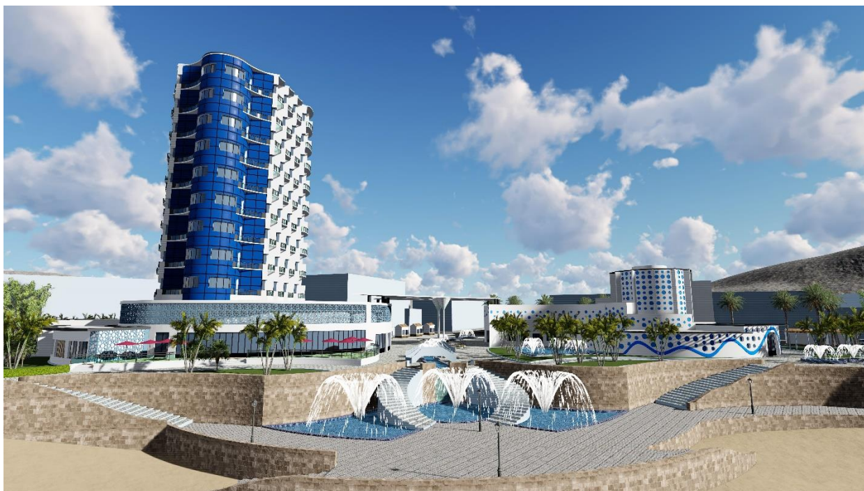
Fig 121 : Traitement de façades
