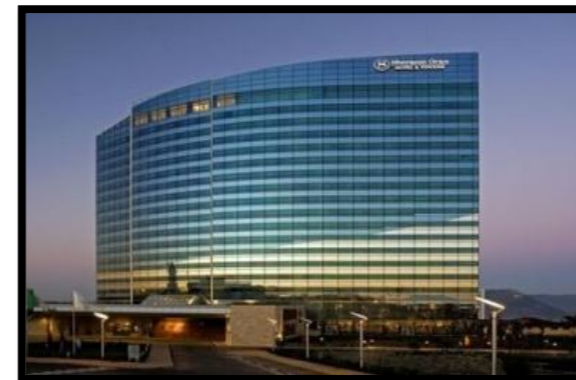
Fig 86 : Les façades de l'hôtel Sheraton
