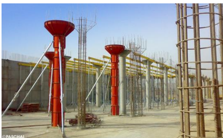
Fig 122 : construction d'un poteau champignon
