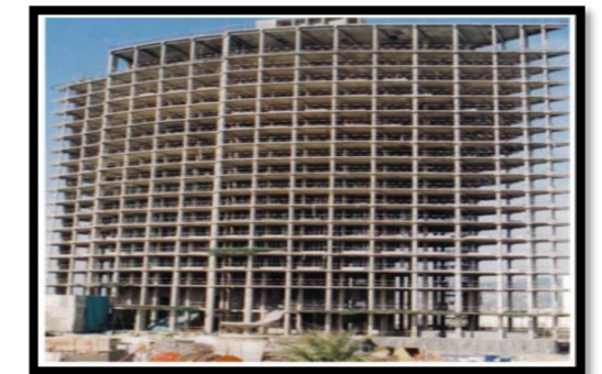
Fig 88 : La structure en béton armé
