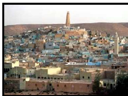
Figure 16 : Le site en pente de la ville de Ghardaïa. Source : Article sur Blogger.com.
