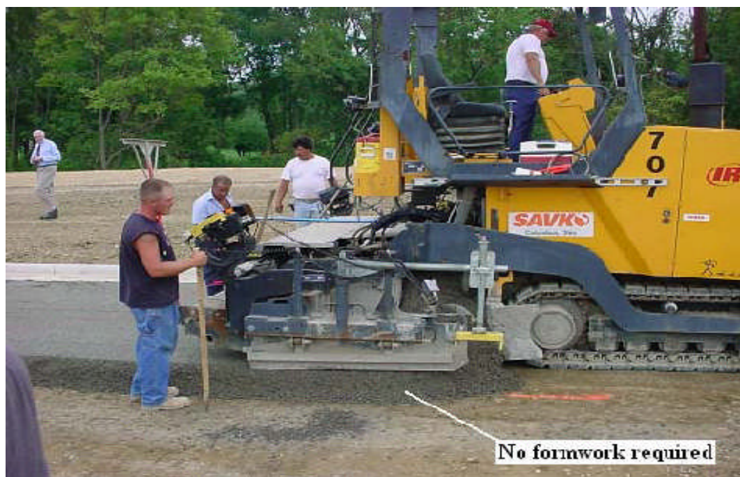
Figure 1.8 : Mise en place du BCR [11].
