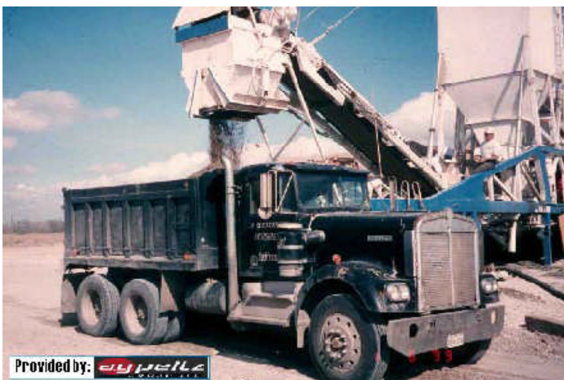
Figure 1.7 : Transport des mélanges de BCR [11].
