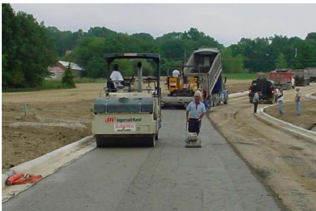
Figure 1.9 : Compactage du BCR après la mise en place [11].
