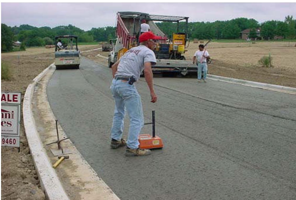
Figure 1.11 : Mesure de la densité par un Nucléodensimètre [11].
