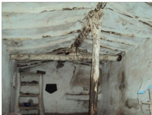
Photo 28:des renforcement a l'interieur Rkiza + Djayza source : auteur 2017
