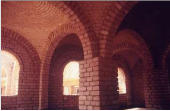
Figure 21 construction en Btc source : architerre.fr
