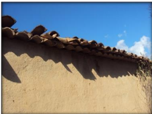
Photo 32 :positionnement de tuile sur le mur source : auteur2017
