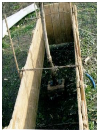
Photo 21 : les banches (Louhat) source : auteur 2017
