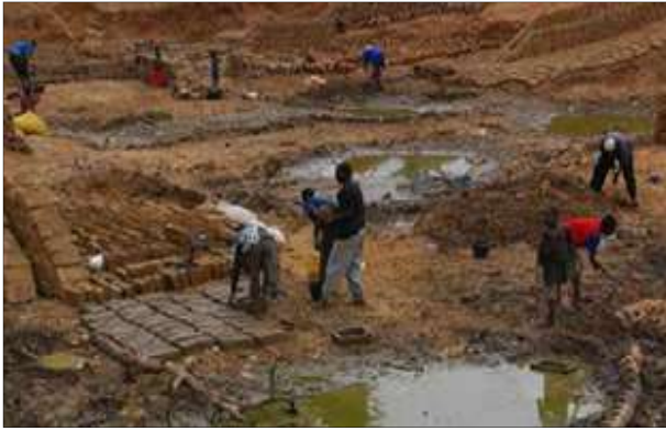
Figure 33 : Fabrication de briques de banco au Mali
