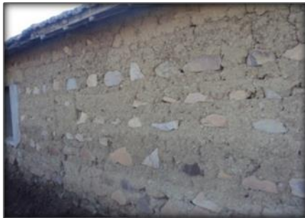
Photo 25:mur en terre en utilisant la pierre source : auteur 2017
