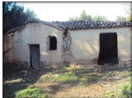
Photo 9 : deux chambres qui donnent vers la cours source : auteur 2017
