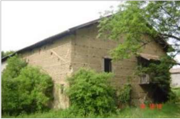
Figure 10 : maison en pisé en région Rome-Alpes source : Slami safia
