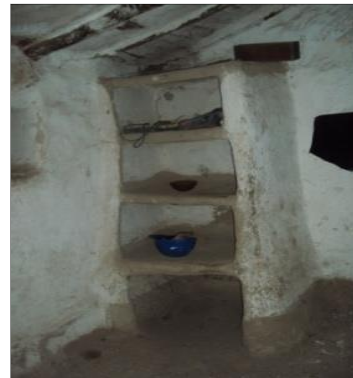
Photo 15 : armoire en terre source : auteur 2017
