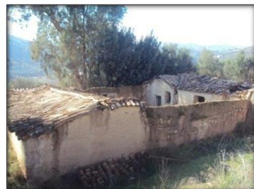
Photo 33 :vue d'ensemble de toiture source : auteur 2017
