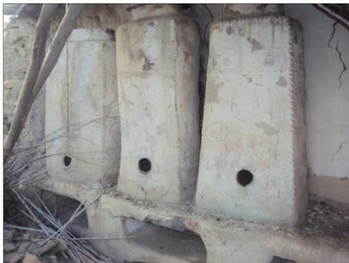
Photo 14 : armoire pour stocker les céréales source : auteur 2017
