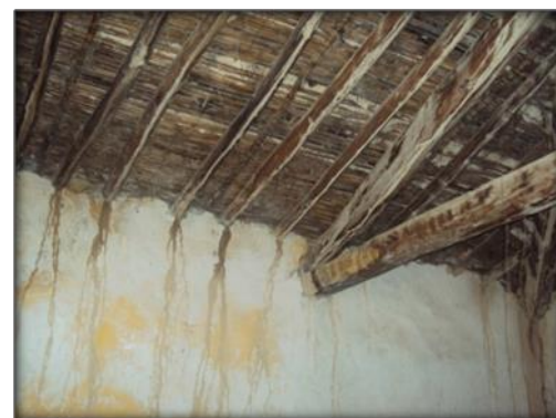
Photo 31:positionnement des segment en bois sur le mur source : auteur 2017
