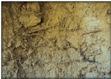
Photo 26 :mur en terre avec des branche d'arbre source : auteur 2017
