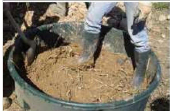
Figure 30 : Construction en terre (technique la bauge) source : la terre crue en architecture globale architecture 2013
