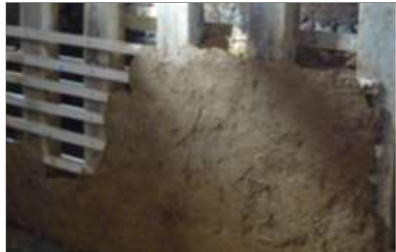
Figure 38 : Technique du Torchis
