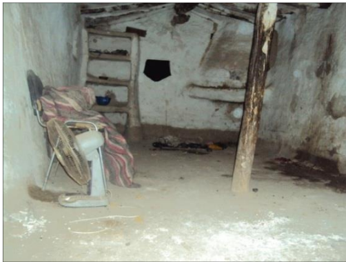
Photo 8 : Chambre à l'intérieur source : auteur 2017
