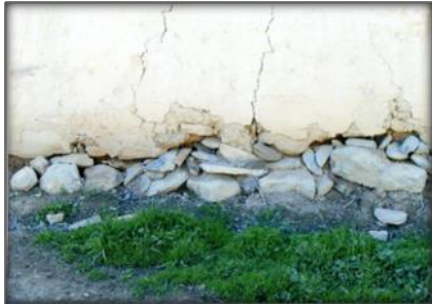
Photo 23:fondation en pierre source : auteur 2017
