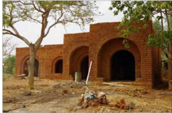
Figure. 18 : BLT et construction en BLT, Burkina Faso source : Jehanne PAULUS
