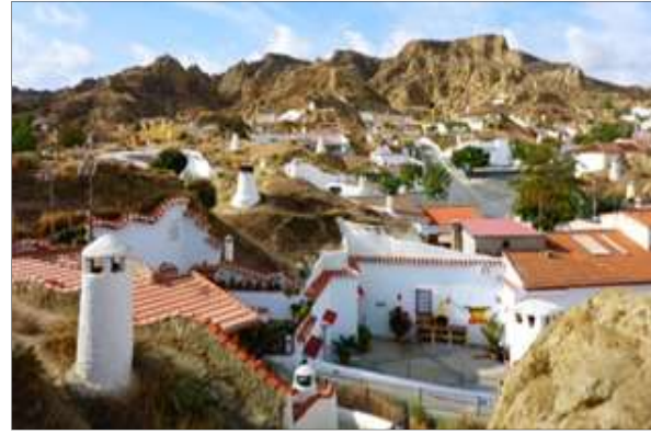
Figure14 : maison à Guadix, Andalousie source : letiziabarcelona.com
