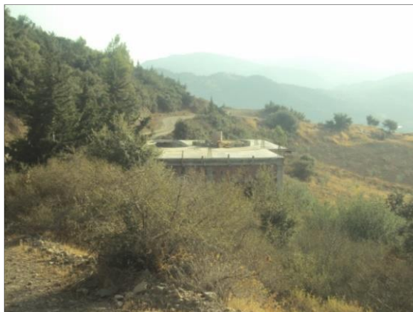
Photo 5 : maison en plein montagne en béton source : auteur 2017
