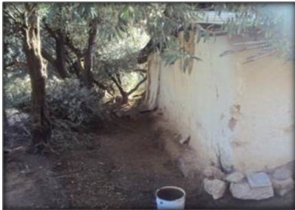
Photo 24:fondation en terre source : auteur 2017
