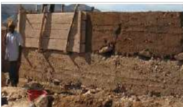
Figure 23 : construction d'un mur banché
