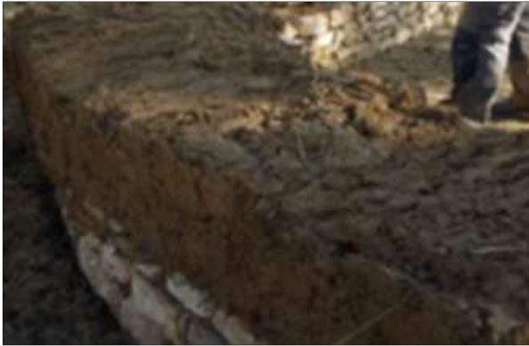
Figure 29 : Construction en terre (technique la bauge) source : : Aymone Nicolas2011
