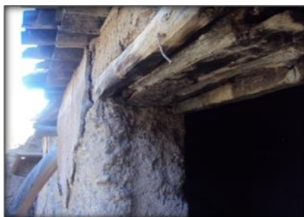
Photo 27:ouverture avec lindeau en bois source : auteur 2017
