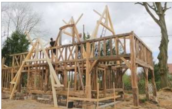
Figure 39 : préparation de structure pour une maison en torchis
