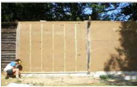
Figure 41 : murs en terre coulée
