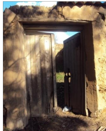
Photo 17 : porte d'entrée source : auteur2017
