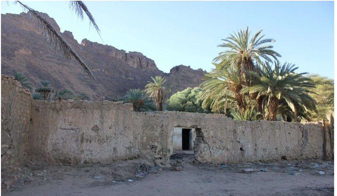
Vue ver la façade extérieure de ksar (arrière)
