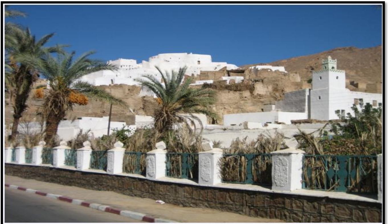
Façade sud ouest de ksar el mihane
