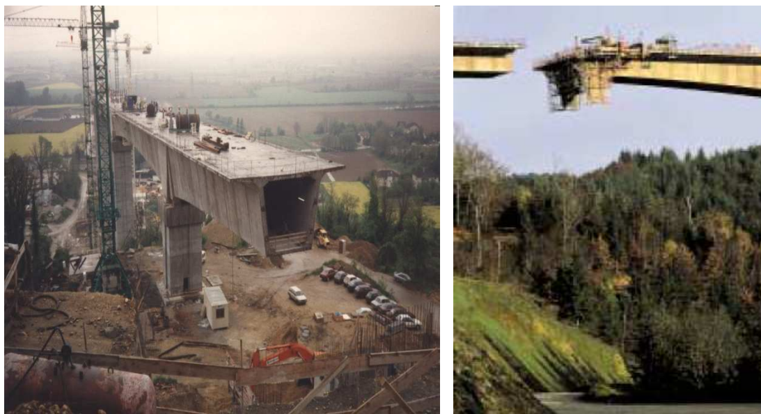
Figure1.31 : Ponts construits en encorbellement [3].
