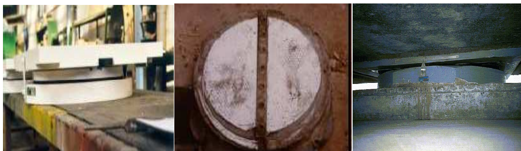
Figure1.3: Appareils d'appui à pot [7].
