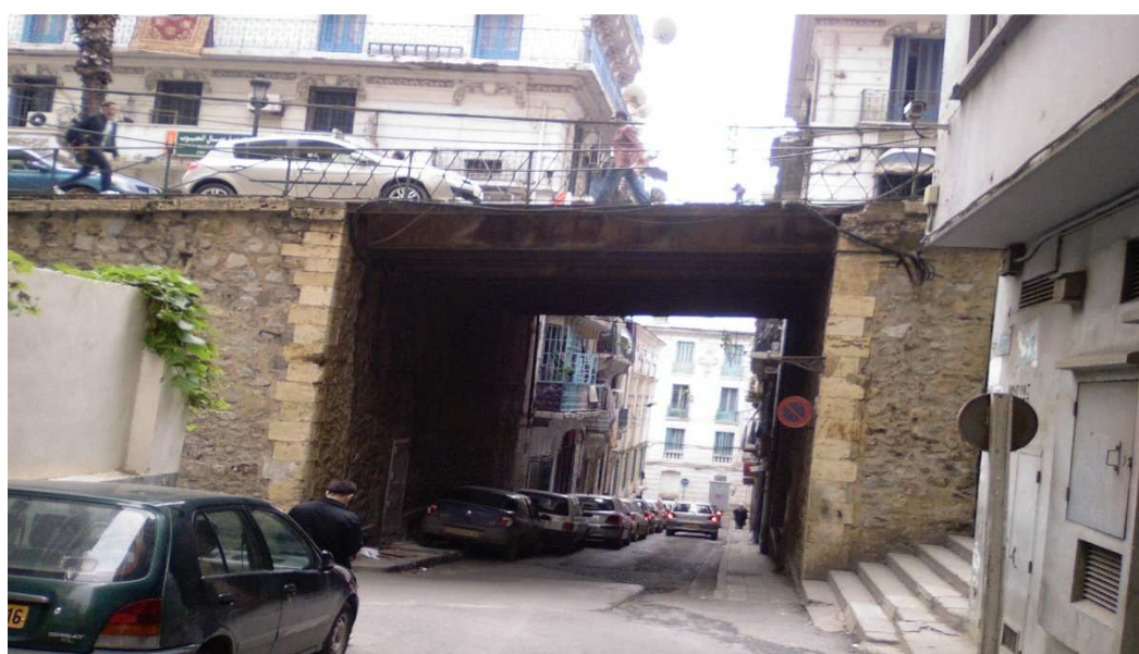
Figure 4.6 : Pont Mohamed V (Alger centre).
