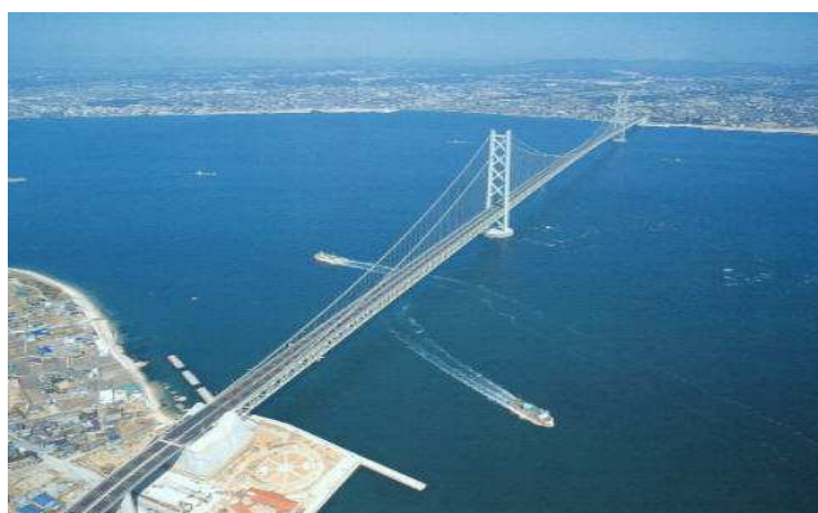
Figure1.16 : Pont suspendu. (Pont d'Akashi Kaikyo, Japon 1998).
