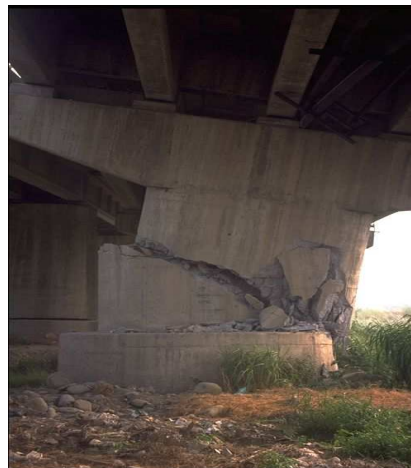
Figure 2.5: Rupture par effort tranchant [22].
