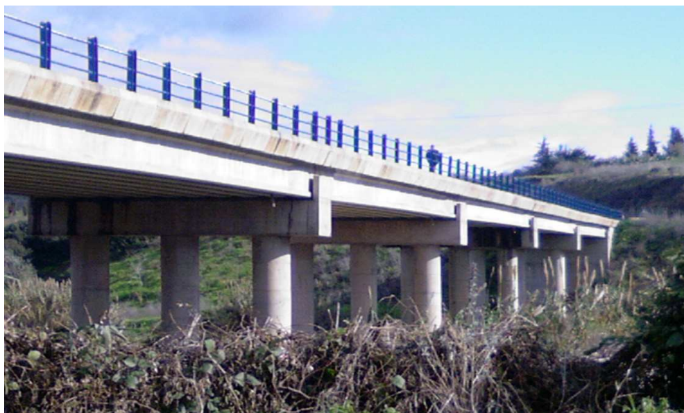
Figure 4.12 : Pont de Hachem (Sidi Amar - Tipaza).
