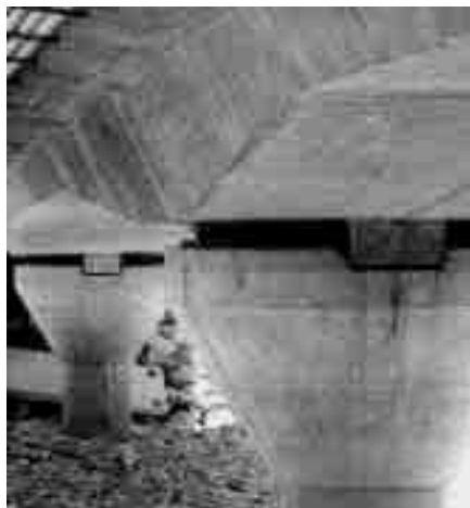
Figure 2.4: Exemple de butées latérales [22].
