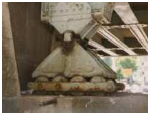
(b) Rotule sur plan de déplacement à rouleaux
