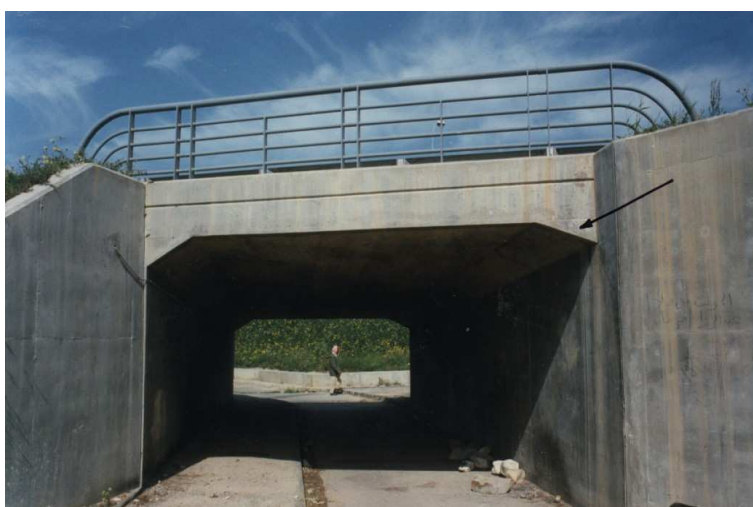
Figure1.13 : Pont en portique fermé.
