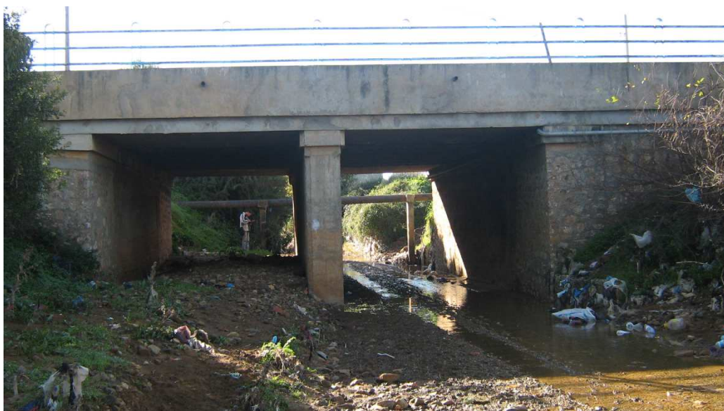
Figure 4.11 : Pont de Bouyaghsane (Hadjout - Tipaza).
