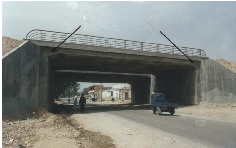
Figure1.14 : Pont en cadre ouvert.
