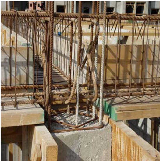
Figure 1.6 : Absence d'armature transversale au nœud .Effondrement dû à cette absence au nœud et dans la zone critique du poteau [47].
