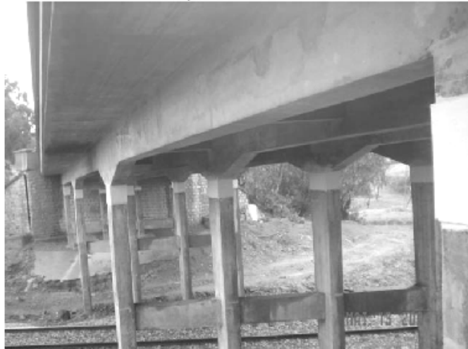
Figure 1.14 : Renforcement des poteaux cisailé par procédé TFC [51].
