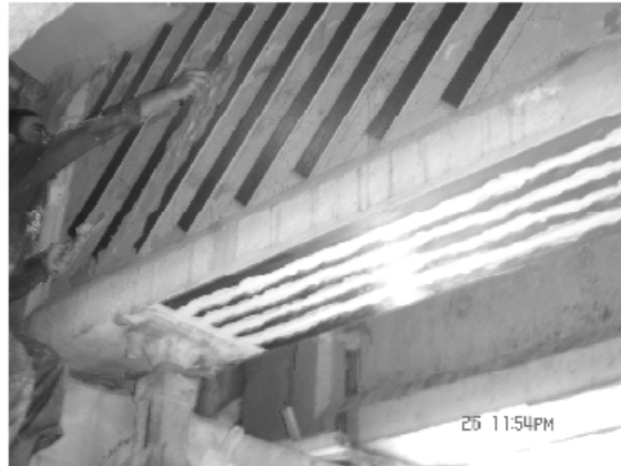
Figure 1.11 : Renforcement par lamelle en fibres de carbone d'une poutre endommagée par le séisme du 21 mai 2003 [51].
