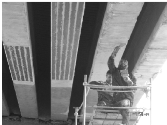
Figure 1.10 : Poutres traitées par mortier de réparation et renforcées par lamelles de fibres de carbone [51].
