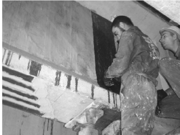
Figure 1.12 : Pose de tissu en fibres de carbone sur la même poutre [51].
