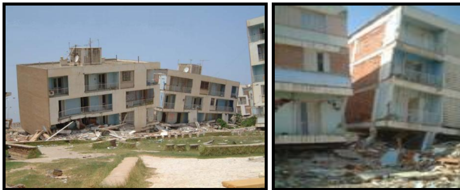
Figure 2.33 : Largeur du joint insuffisant entre les deux bâtiments ( Séisme de Boumerdes 2003 )
