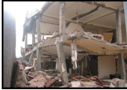
Figure 2.29 : Rotules plus accentuées aux extrémités des poteaux du premier niveau à la limite de l'effondrement. (Séisme de Boumerdes 2003)
