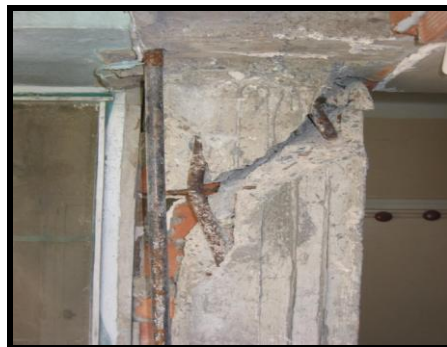
Figure 2.30: La Rupture du nœud poteaux – poutres avec flambement local des aciers longitudinaux par manque de frettage des aciers transversaux (Séisme de Boumerdes 2003)
