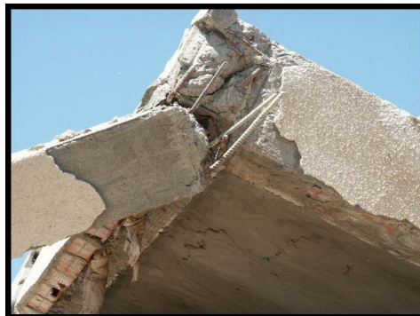
Figure 2.30: La Rupture du nœud poteaux – poutres avec flambement local des aciers longitudinaux par manque de frettage des aciers transversaux (Séisme de Boumerdes 2003)
