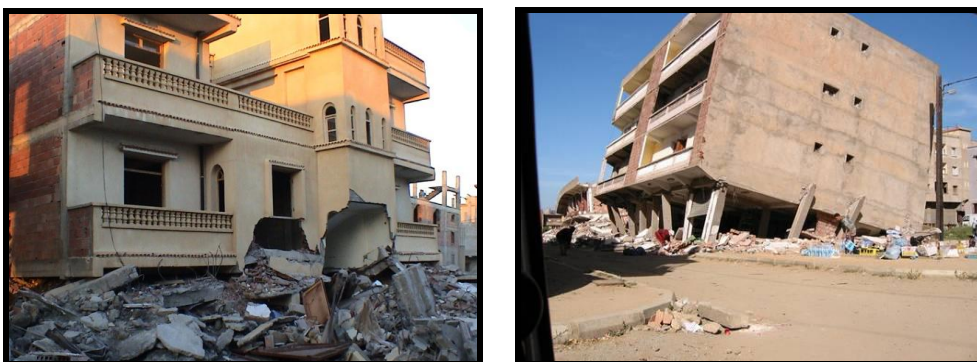
Figure 2.39: Perte du premier niveau avec perte d'appuis quasi simultanée d'appuis sur les poteaux RDC et renversement vers l'arrière. ( Séisme de Boumerdes, 2003 )
