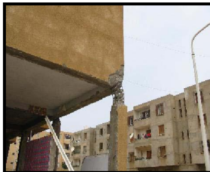
Figure 2.27 : La section des poteaux étant souvent équivalente à celle des poutres, la plastification des nœuds se produit en tête ou en pied de poteau ( Séisme de Boumerdes 2003 )
