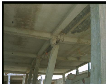
Figure 2.27 : La section des poteaux étant souvent équivalente à celle des poutres, la plastification des nœuds se produit en tête ou en pied de poteau ( Séisme de Boumerdes 2003 )
