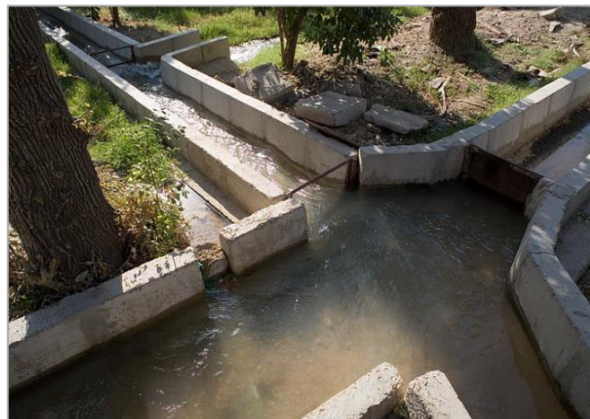
Figure.3.11 : Déviation des eaux d'une Seguia par de simple mottes de terre
