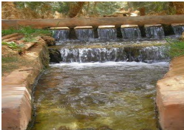
Figure.3.5. Petits ouvrages composés de barrages dans l'oasis du M'zab
