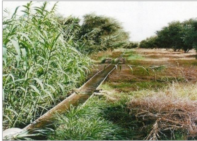
Figure.3.10 : Canal d'irrigation à ciel ouvert (Seguia)
