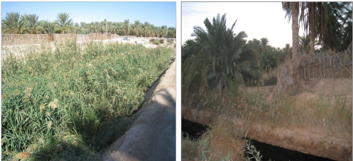
Figure.3.20 : Envahissement des fossés et des palmeraies par les roseaux [23]
