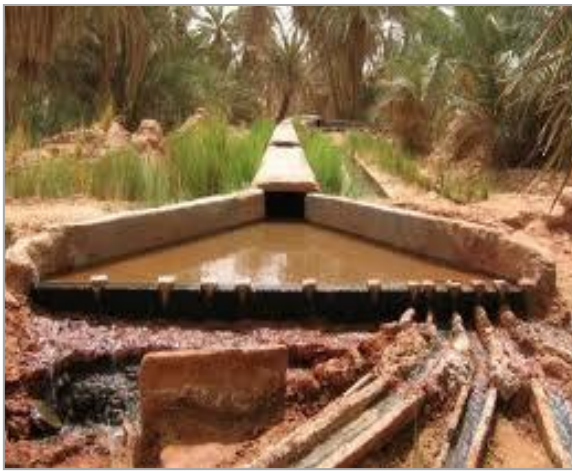
Figure.3.8: Bassin de collecte des eaux issue de la Foggara (Madjen)
