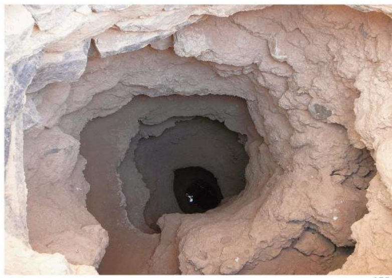
Figure.3.17 : Photo d'une galerie drainante souterraine (Edd.IRD)
