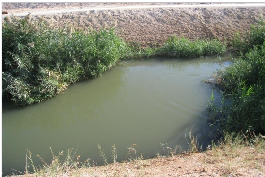
Figure.5.5 : Drain colmaté avec risque de stagnation des eaux dans la vallée [23]
