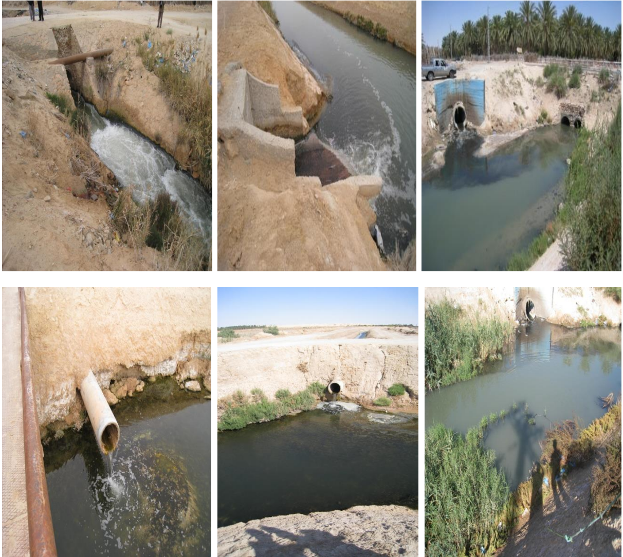
Figure.6.8 : Points de déversement des eaux usées dans le canal de l'Oued Righ[23]
