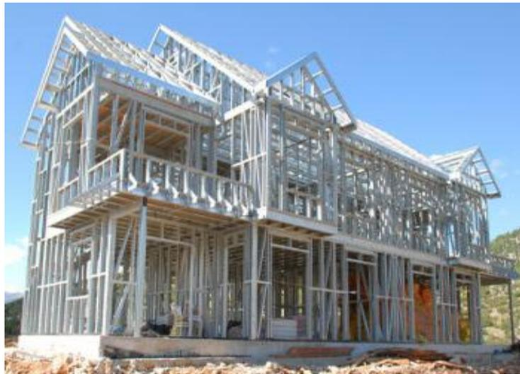
Figure 1 : Structure métallique à base de profilés formés à froid
