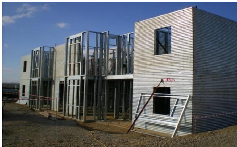
Figure 1 : Ossature d'une structure à base d'acier formé à froid CFS.
