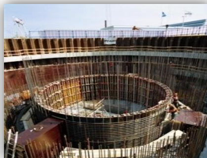
.figure 137 : Exemple d'un ferrailage de noyau central Source : http://tpe--lesgratte-ciels.e-monsite.com
