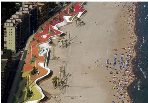
A- Aménagement des balcons dans la promenade maritime Benidorm. Espagne. Source : www.vimeo.com . Consulter le 16/12/2018
