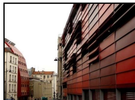
Figure 19 : la façade de l'immeuble donnant sur la rue
