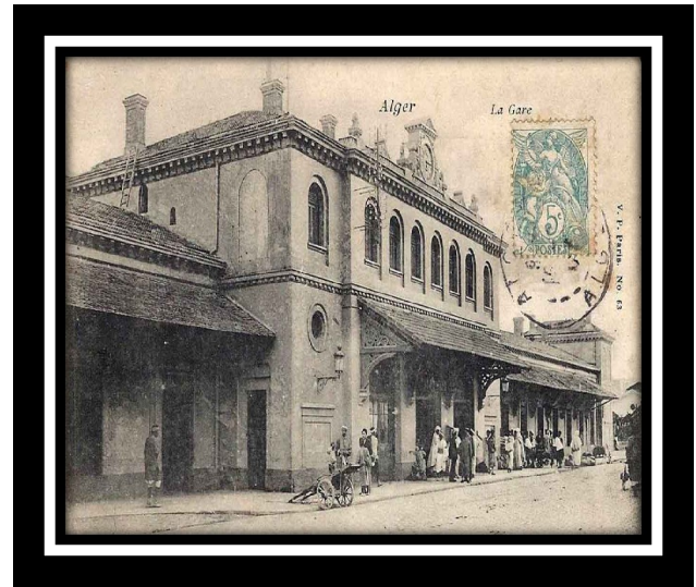
Fig 01 :Vues sur la gare intérieure d'Alger
