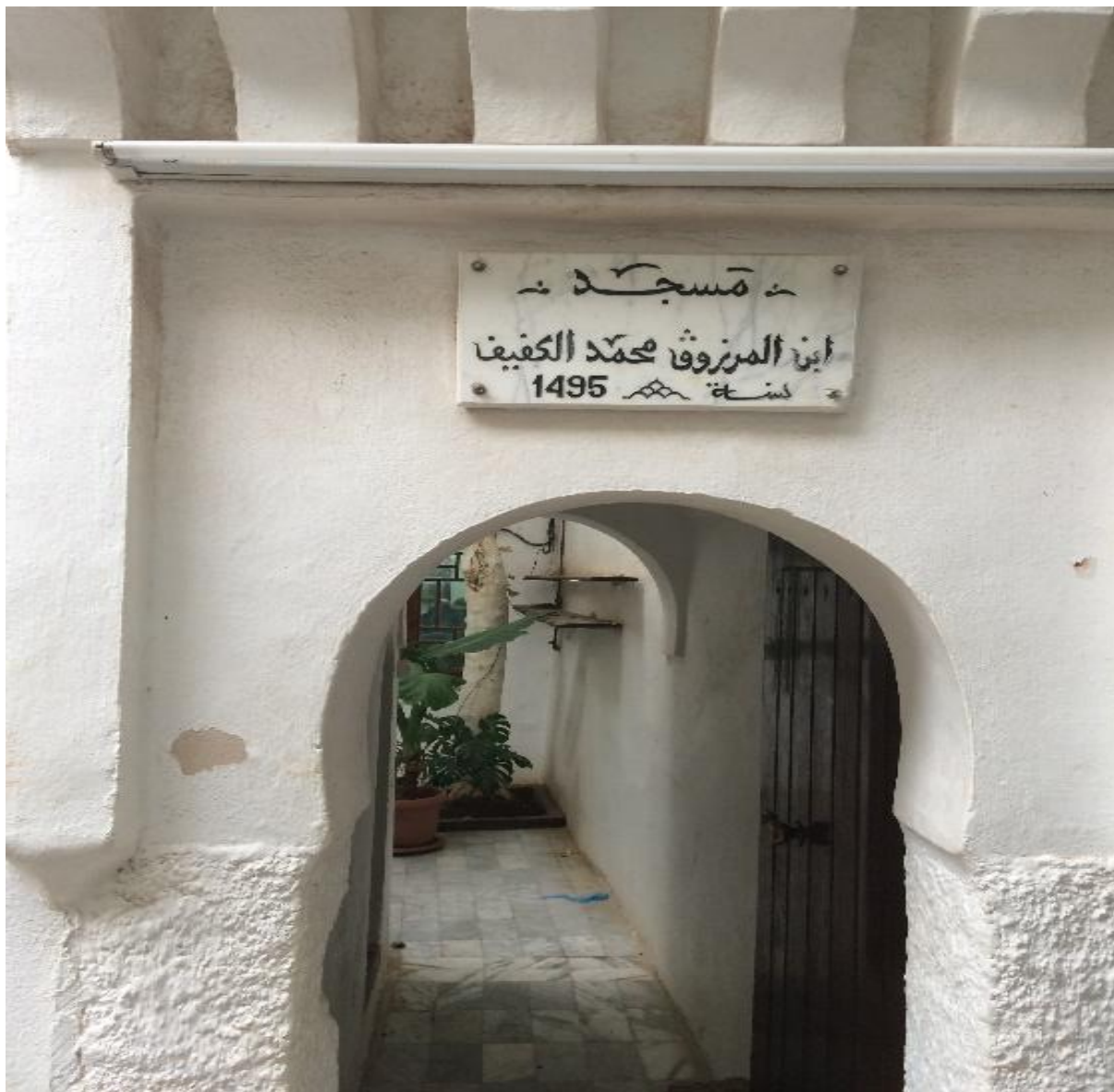
Fig. Mosquée Ibn El Mérouk Contexte urbain direct de la zaouia Alaouia
