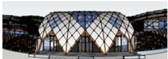
Figure 137 : vue sur le hall d'accueil. Source : auteur.
