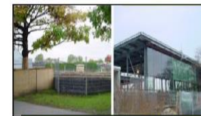
PROTECTION DES ARBRES EXISTANTS
