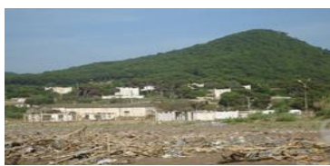
Figure 79 : la Présence d'équipements en mauvaise état. Source : auteur
