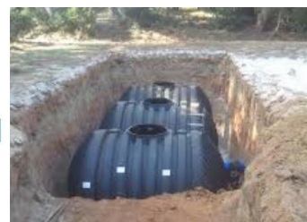
Figure 6 : les collecteurs souterrains source : Google image.
