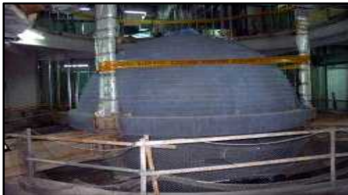
Figure II. 67 : une boule d'acier. (Source :site web :drainagequebec)
