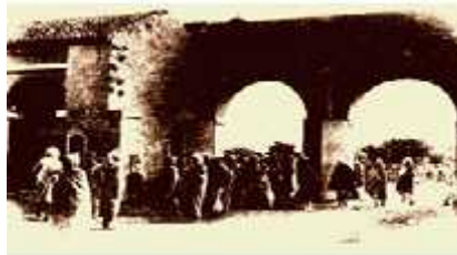
Figure III. 12: la porte de Biskra. (Source : site web : carte-algerie)
