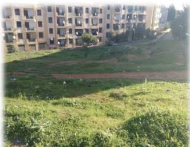
Figure 52: site d'intervention Source : auteur
