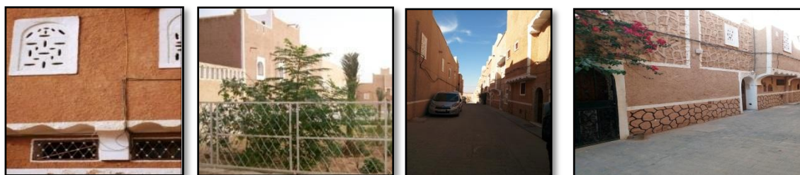
Fig I.23. les éléments de protection solaire a Tafilelt des ouvertures et texture rugueuse source : pris par auteurs
