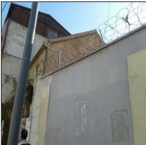
Figure 73: Le mur de clôture de l'institut Sonelgaz Source : pris par Les auteurs le 22/12/2018 A 13 :52.
