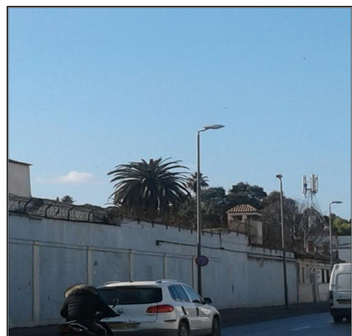
Figure 74 Le mur de clôture de l'institut Sonelgaz Source : pris par Les auteurs le 22/12/2018 a 13.53
