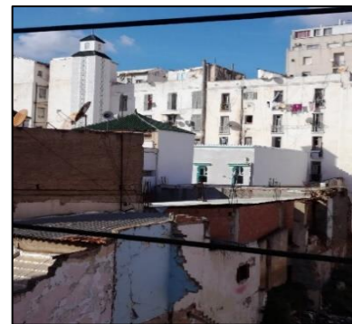
Figure 45 : Bati en mauvaise Etat Source : Les auteurs 2018
