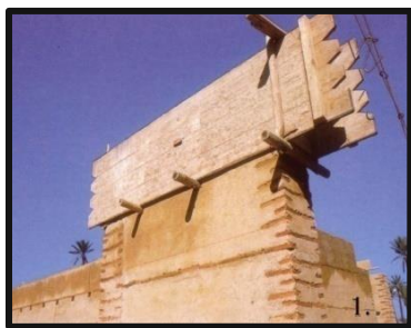
Figure 16: Technique de coffrage de pisé (Source: https://fr.wikipedia.org )
