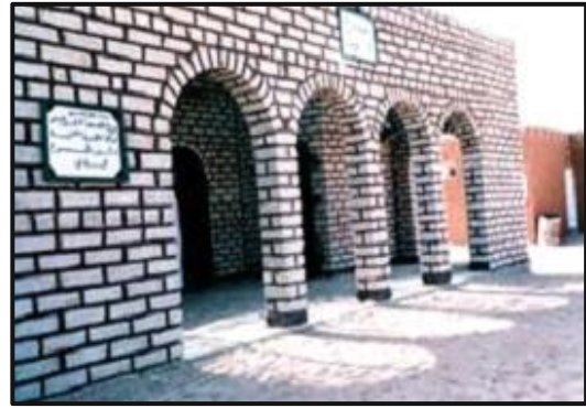
Figure 23: Edifice public réalisée BTC à Tamanrasset (Source: CNERIB Algérie)
