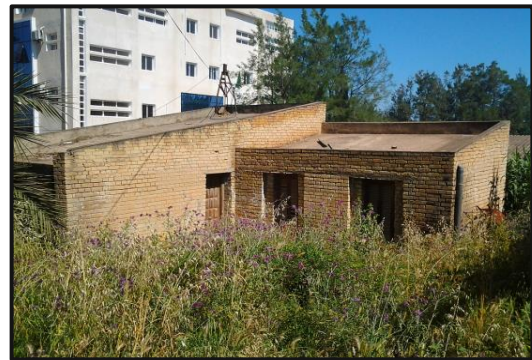
Figure 25: prototype en BTC réalisé en 1984 au CNERIB (Source: CNERIB Algérie)
