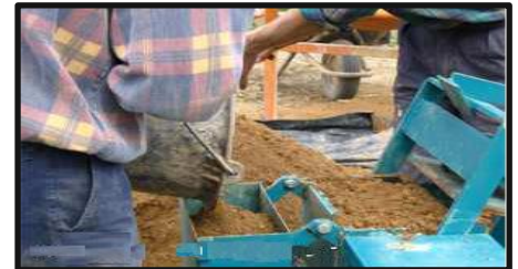
Figure 07: Remplissage du moule (Source : http://www.appro-techno.be/ )
