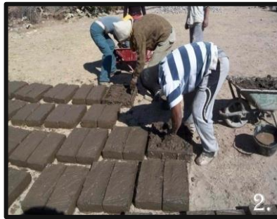
Figure 2: Lissage (Source : Encyclopédie interactive Wikipédia)
