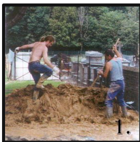
Figure 8: Le malaxage de la terre (Source : Encyclopédie interactive Wikipédia)
