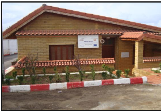
Figure 24: Prototype en BTS réalisé en 2007 au CNERIB (Alger) (Source: CNERIB Algérie)
