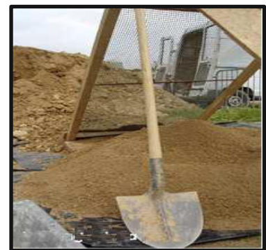
Figure 05: Le tamisage de la terre (Source : http://www.appro-techno.be/ )
