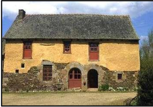
Figure 14: Maison construite en bauge a Costa Rica (Source: Adobe guide de construction en terre ,Wilfredo Carazas édition :CRATerre)
