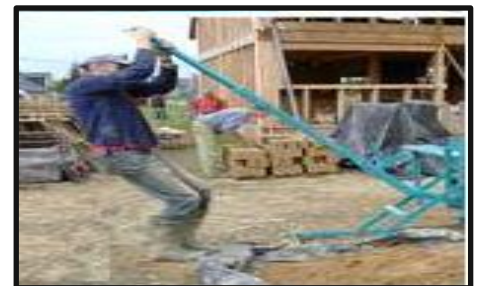
Figure 09: Compactage des blocs (Source : http://www.appro-techno.be/ )
