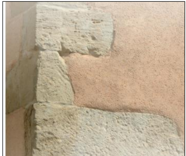
Figure 01: Mortier de Chaux
