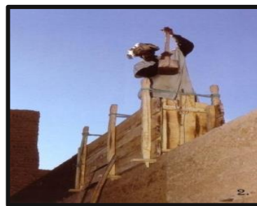
Figure 17: Technique de compactage de pisé (Source: https://fr.wikipedia.org )
