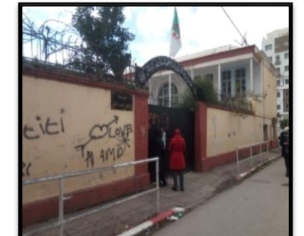
Figure 43 : La Façade Principale Source : Auteur
