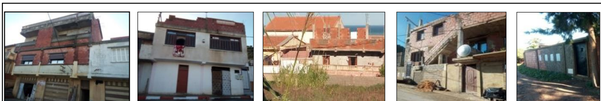
Figure III.48 : Habitats individuels de différentes gabarries Source : auteurs 2019
