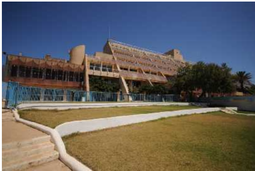
Photos: vue sur le projet.
