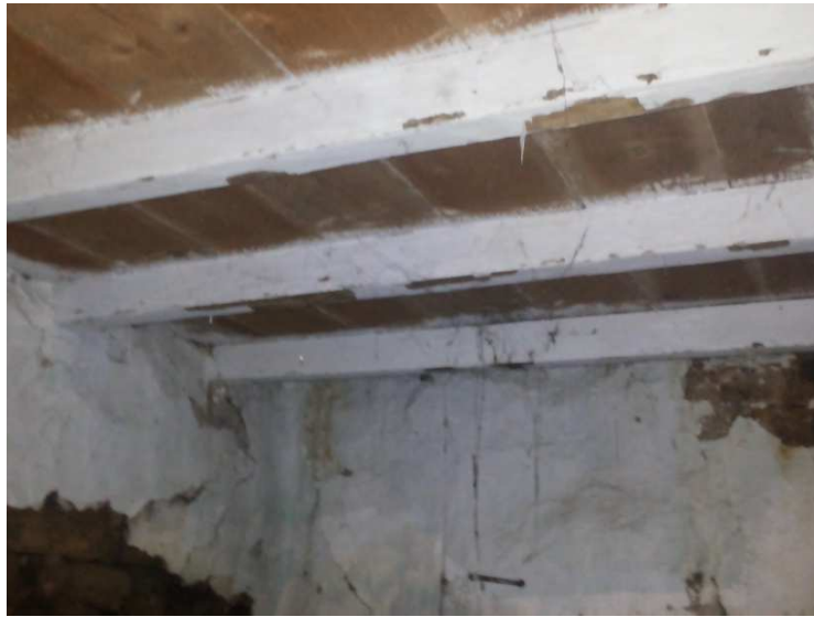
Photo 39 : Plancher au bois usiner.
