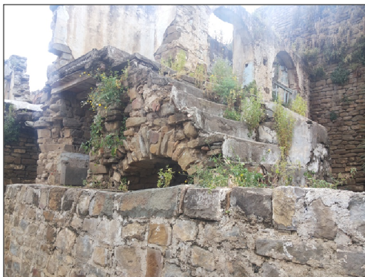
Photo 42: escalier posé sur la voûte.
