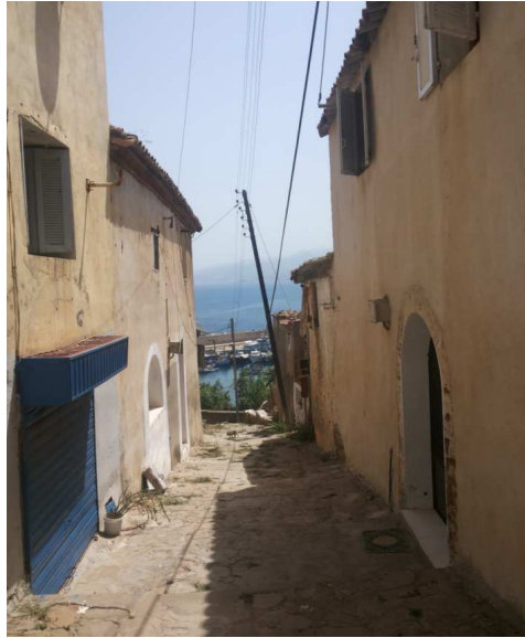
Photo 28 : percé sur la mer, la basse casbah. Source: Auteur.
