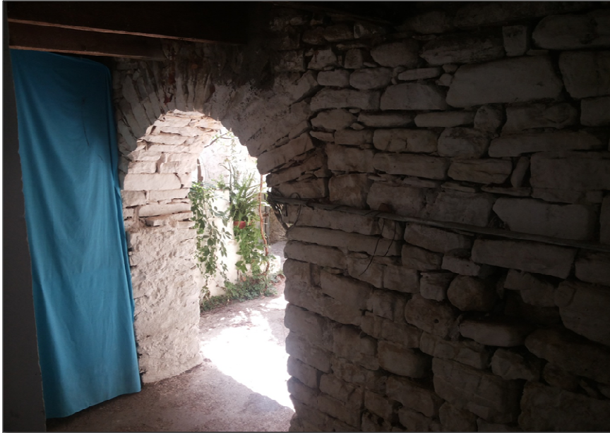
Photo 37 : l'entrée de la maison. Source: (Auteur 2017)
