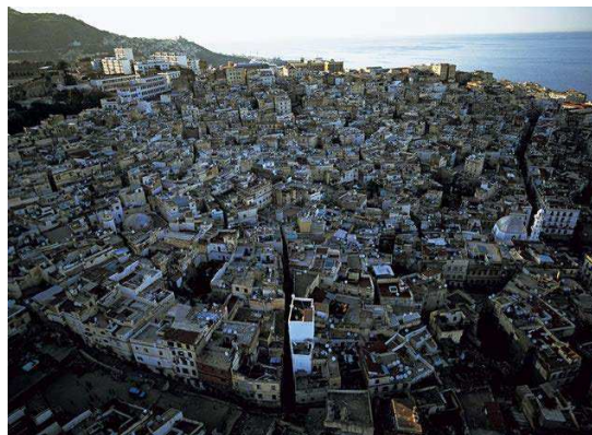
Photo 11: Photo aérienne de la casbah d'Alger
