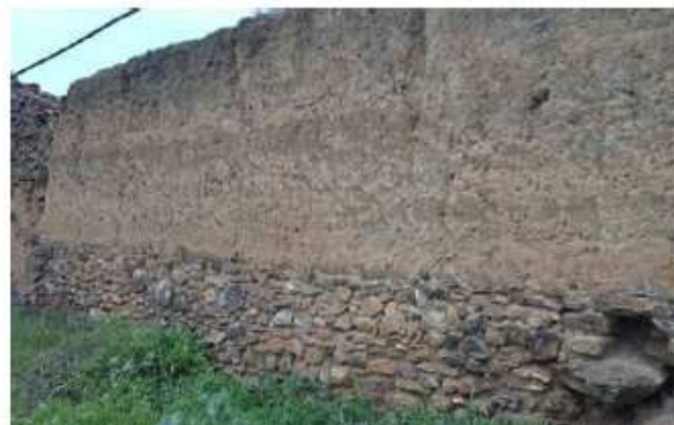
Photo 10 :mur en pisé avec soubassement en pierre .village Seddouk.Bejaia. source: Allili sonia(2012).
