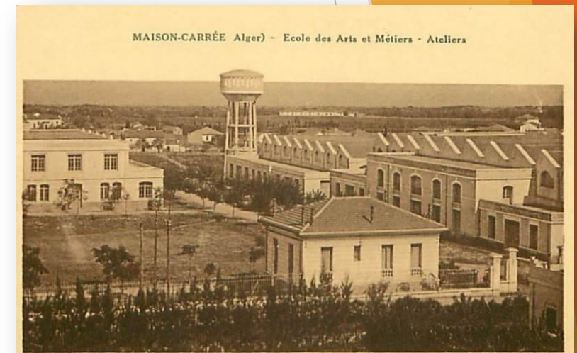
Fig. 05.7: vue sur les différents ateliers de l'école Source : https://www.judaicalgeria.com/pages/maison-carree .
