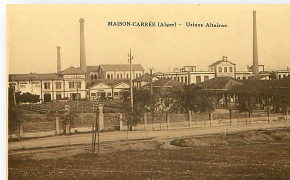
Fig. 05.19: vue sur les différents bâtiments d'usine Source : https://www.judaicalgeria.com/pages/maison-carree .
