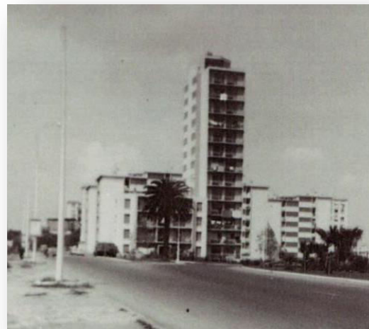
Fig. 05.24: vue sur la façade principale du bâtiment. Source : https://www.judaicalgeria.com/pages/maison-carree .
