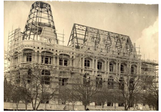
Fig. 02.14 : la réalisation d'une charpente entièrement métallique.
