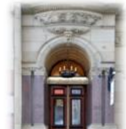
Fig. 02.9 : traitement des façades /les éléments architectoniques
