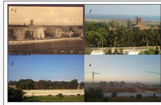
Photos 05.15: les différents vue sur l'édifice Sources :archive de l'apc
