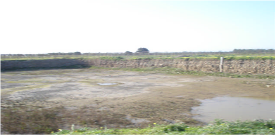
Bouinan, recharge artificielle de la nappe : bassin d'infiltration à l'arrêt
