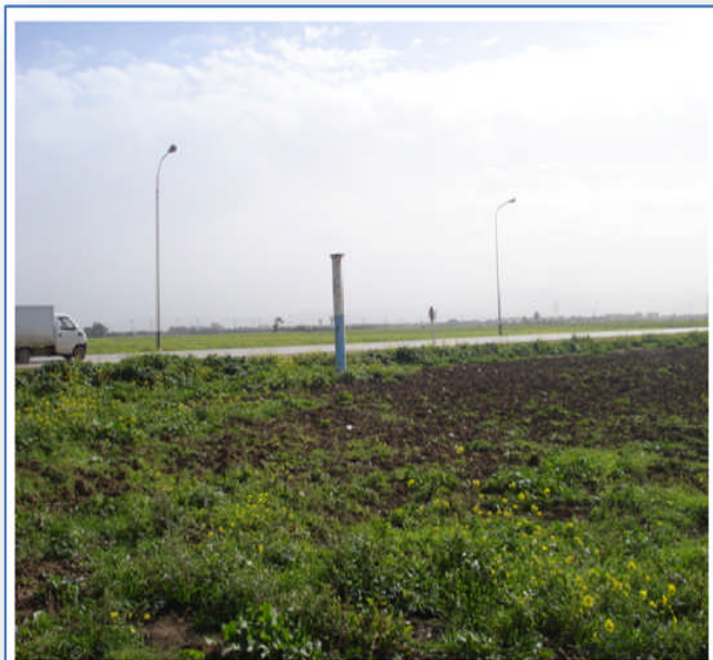
Un piézomètre installé, à deux km de la baie d'Alger, sur le domaine BenZarga pour contrôler la qualité des eaux souterraines et le niveau de rabattement de la nappe
