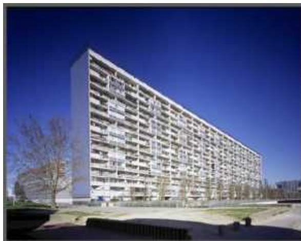
Figure 7 : La « cité des 4000 » à La Courneuve
