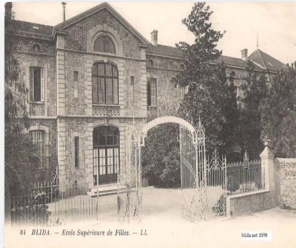
Figure 32: Vue ancien de Lycée El Fath (Ex Ecole supérieure de Filles) Source : www.google.com
