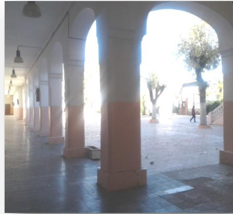
Figure 38: Vue récente sur le couloir donnat sur la cour de l'Ecole Bonnier (Essenhadji) Source : Photo prise par « Marouf »
