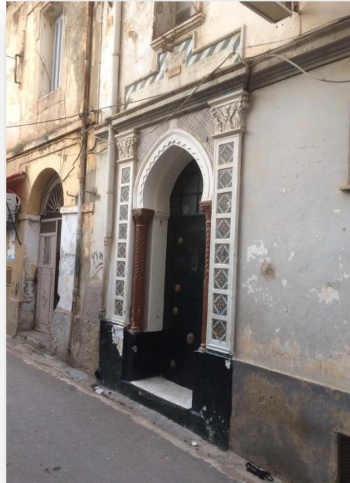
Figure 61: Vue récente Hammam DENNANE
