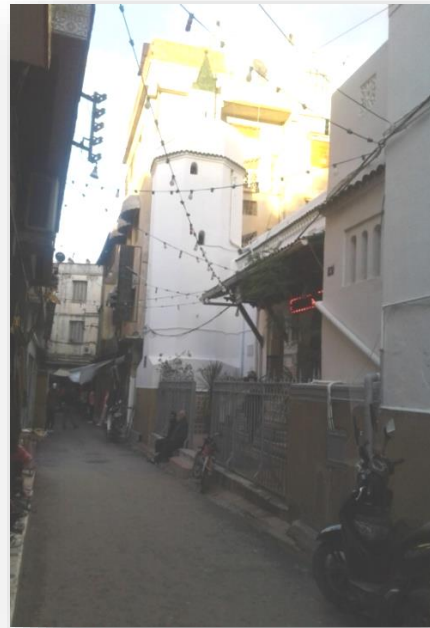
Figure 13: Vue récente sur la Minaret de la Mosquée EL HANAFIYA Source : Photo prise par « Marouf »
