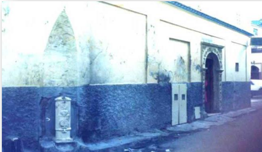
Figure 59: Vue sur Hammam « Bacha Agha » avant sa démolition Source : Ben Chama Souad
