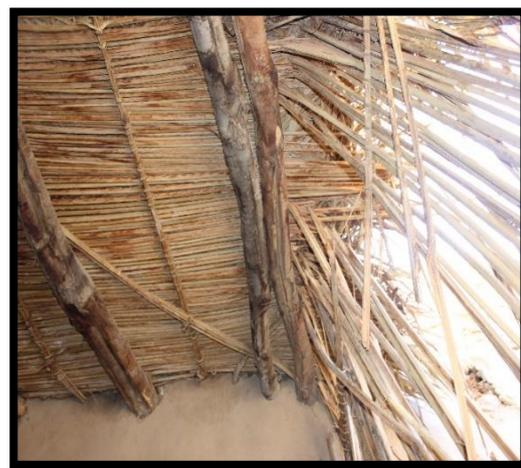
Figure 44-45 Utilisation du Jrid du palmiers dans la construction du plancher Adjahil .
