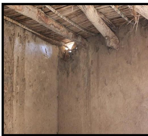
Figure 42-43 Utilisation des troncs des palmiers dans la construction du plancher Adjahil
