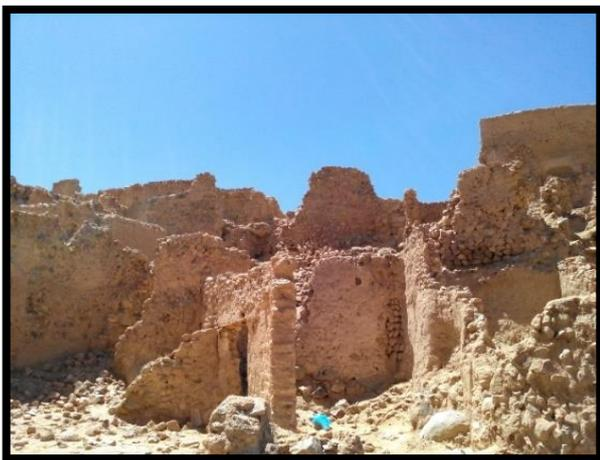
Figure 16 l'Etat dégrade du bâti du ksar Elmizan
