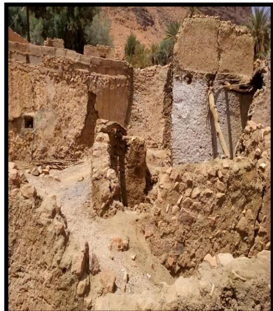
Figure 32 et 33. Enduit extérieur en argile ksar Adjahil
