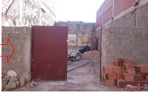
fig 41: Maison démolie après vente. source: Auteur2016.
