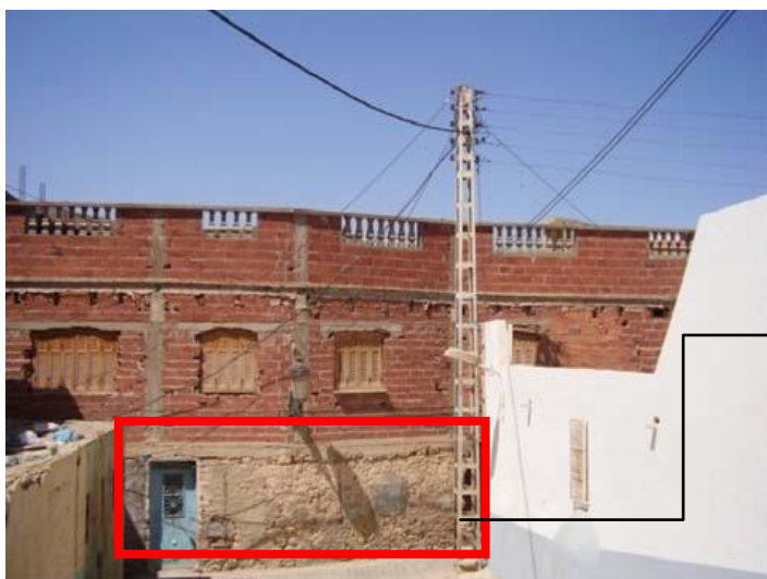
fig52 : Mur en pierre .
