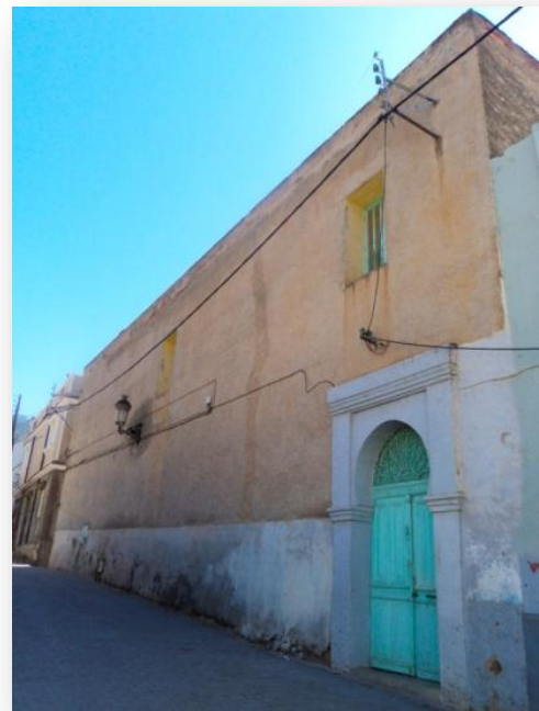
fig 33: Façade de Dar el -Senhadji .
