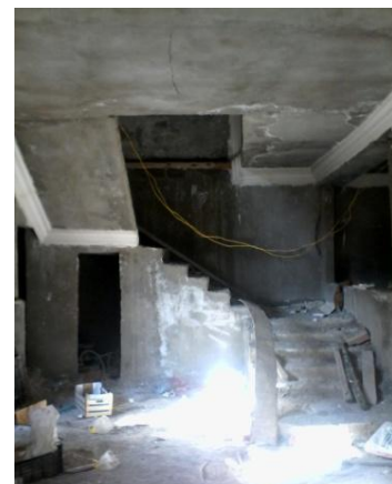
fig 60: : l'intérieur de la nouvelle maison
