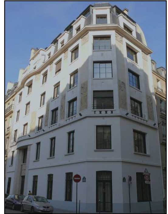
Fig. I.10. : Immeuble de bureau de la société financière française et coloniale 1929, 34 rue Parquier Paris
