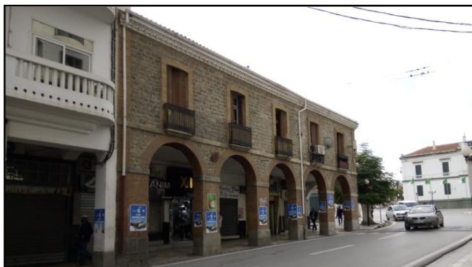
Fig.III.11. façade de l'immeuble 39 Source : auteur
