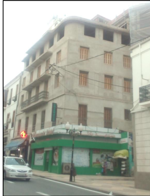
Fig.III.37. état des lieux d'une façade se trouvant sur la rue Abane Ramdane source : auteur 2017
