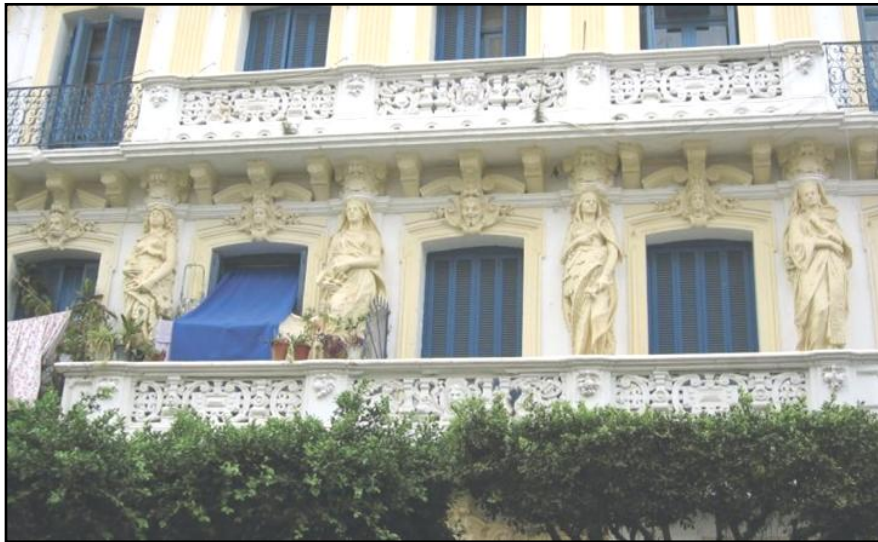
Fig. II.22. Façade ouvragée Alger centre, source : Jean-Paul LABOURDETTE
