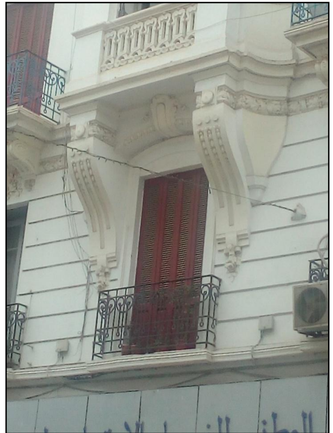
Fig. II.21. Ornementation sur un immeuble à la Rue Abane Ramdane Constantine source : Auteur
