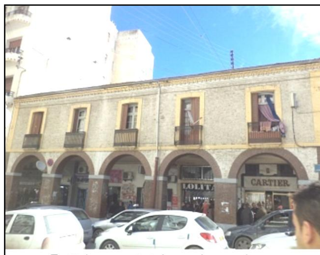
Fig.III.12. façade de l'immeuble 39 avant les travaux de ravalement Source : archive
