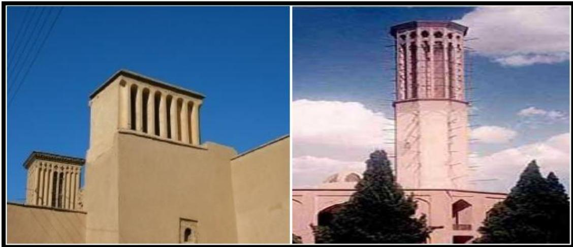
**Figure I-30:** Exemple de cheminée de ventilation traditionnelle (tour de vent) en Iran
