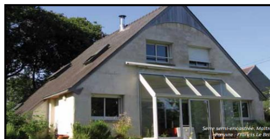
Figure20 : la serre solaires passives intégrées à la maison/ Source ;www.apte-asso.org
