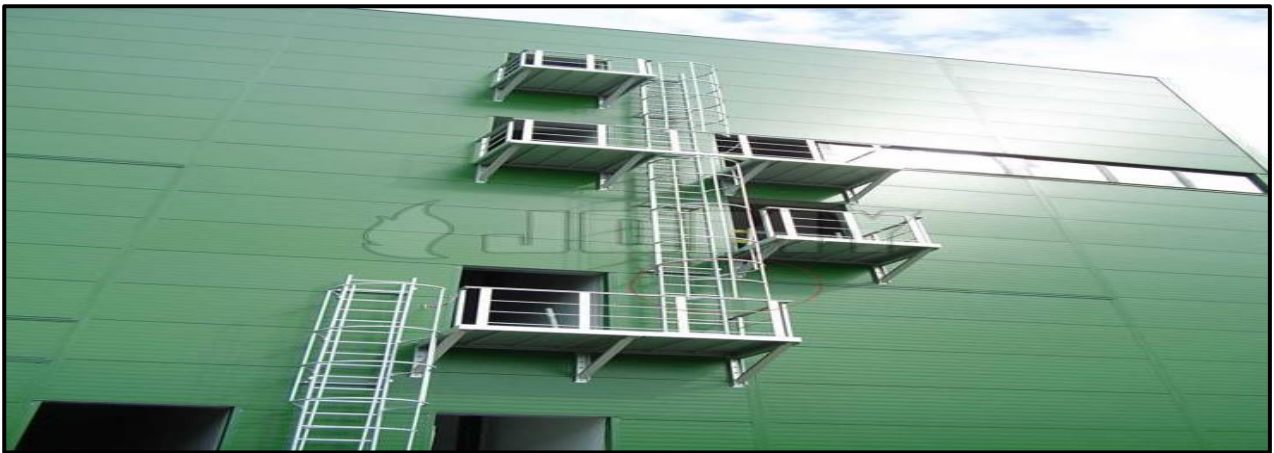
Figure 1 :escalier de secour
