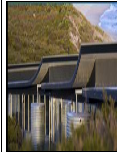
Figure 51: Vue de la toiture /Source : www.destinationhotels.jp
