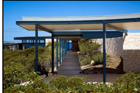
Figure 47: Façade principale de l'hotel /Source : www.designhotels.com
