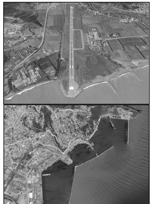
Figure 30: Le port et l'aéroport de Bejaia : source : algeriaspace.blogspot.com
