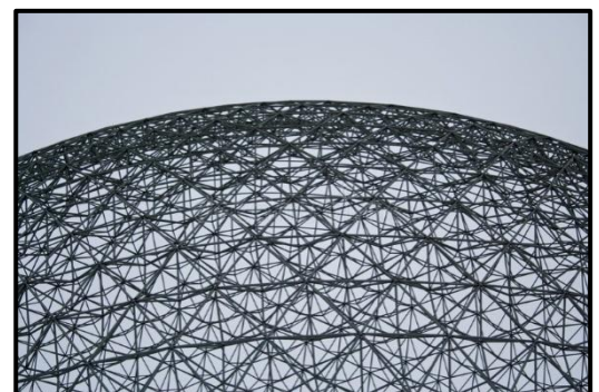
Figure 59 structure métallique- système tridimensionnel-
