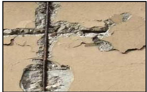
Figure 15 L'effet de la corrosion sur la structure
