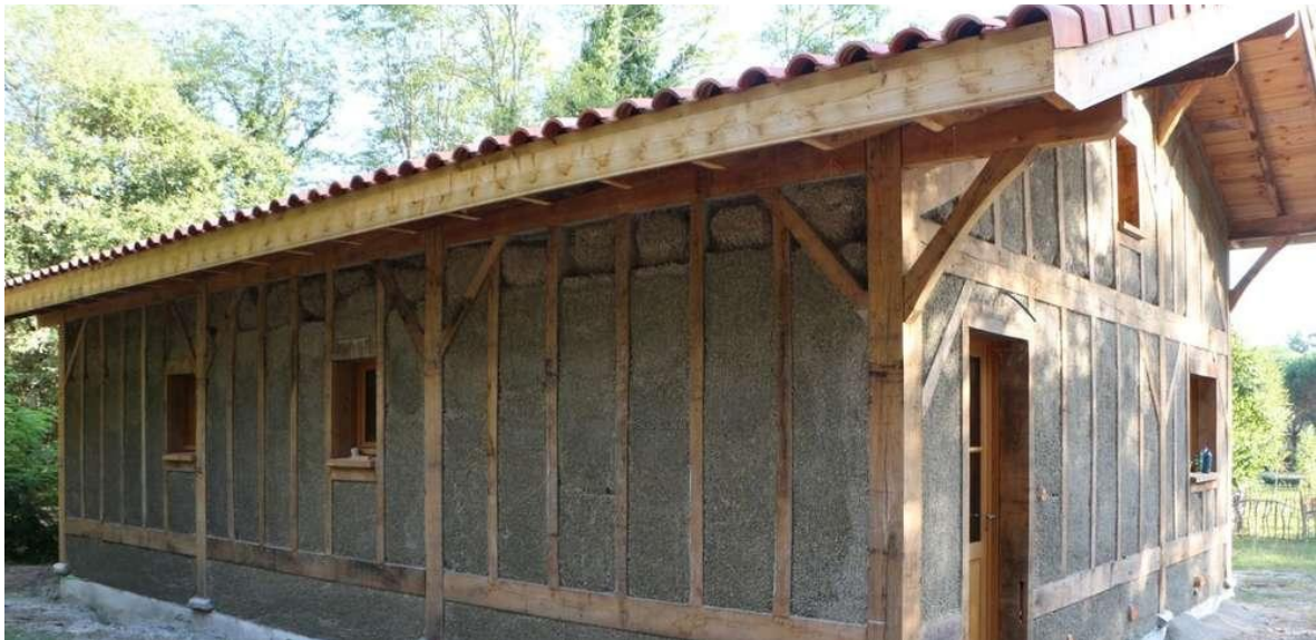
Fig N° 16 : Une maison en bois avec des murs en béton
