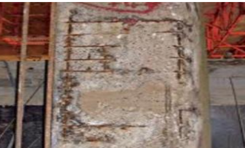
Fig N° 22 : L'effet de l'humidité sur le béton.
