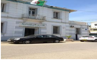
Fig N °113: la mairie de Zeralda source : mémoire de soutenance
