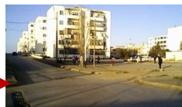
Fig N° 122: Cité des 500 logts a Zeralda source : photo prise par les étudiants
