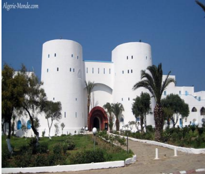
Fig N° 97: Complexe de Matrès - Algerie
