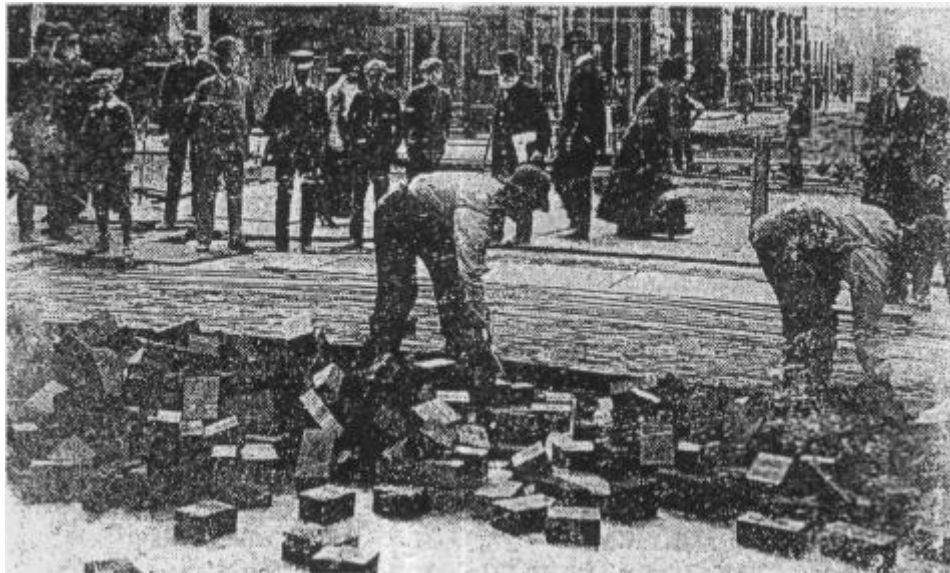
Figure 1.1 Revêtement de chaussée par blocs de bois Oslo 1914
