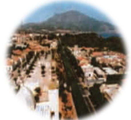
Image04: la placette sur un plan surélevé garde toujours le contact visuel et regroupe les édifices publics
