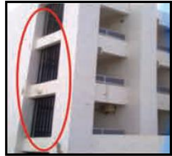
image 03: Des pare-soleil verticaux pour la protection solaire
