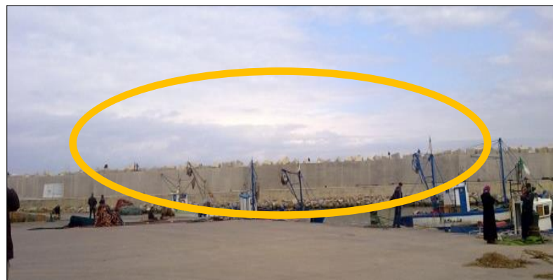
Image 02: La construction des jetées obstrue la vue vers la mer.
