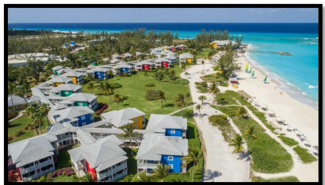
Figure 8 : Vue 3d (Club Med). Source : Google image
