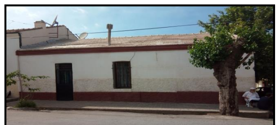
Figure 81 : Photo de la maison.
