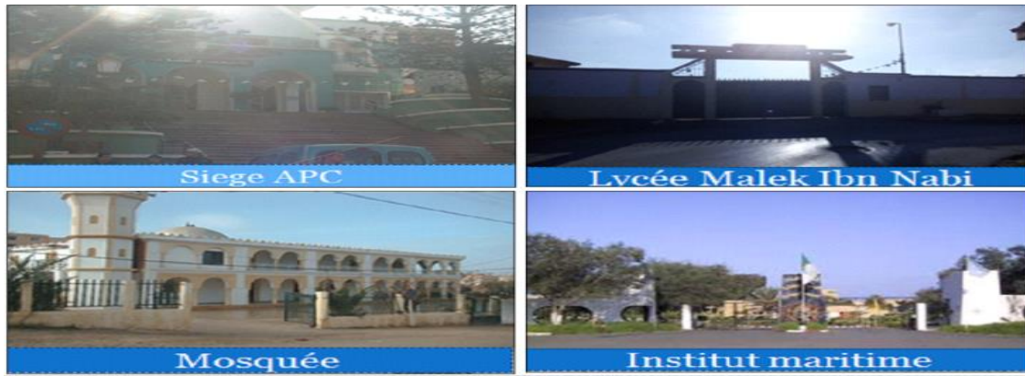
Figure 72 : Photos des équipements major de Bou Ismail. Source : PDAU/ Auteur.
