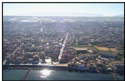
Figure 22 : Vue sur la ville de Bou-Ismaïl. Source : Google image
