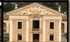
Fig5: Façade d'un édifice classique.
