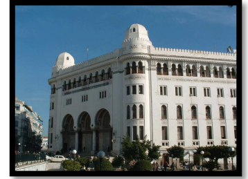
Figure 40 La grande poste d'Alger
