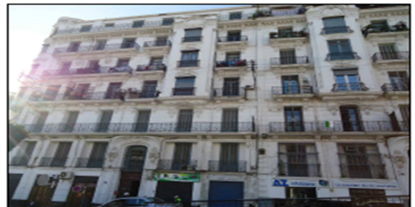
BATIMENT PLUS DE R+5 SUR LE BOULEVARD KHEMISTI
