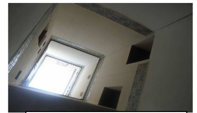
Fig66 Maison à chebek Casbah
