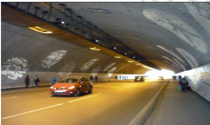
TUNNEL DES FACULTES
