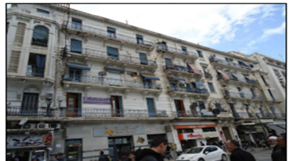
BATIMENTS R+4 SUR LE BOULEVARD C.AMIROUCHE
