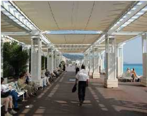
Figure 52: aménagements des pergolas promenade des anglais Nice (France).
