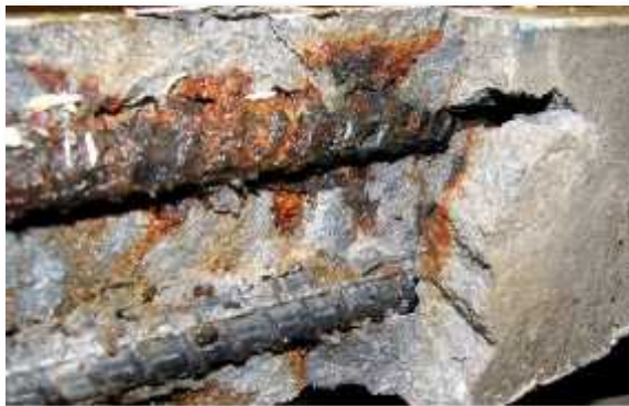
Figure 27:exemples de corrosion du béton armé.
