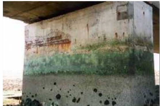
Figure 27:exemples de corrosion du béton armé.
