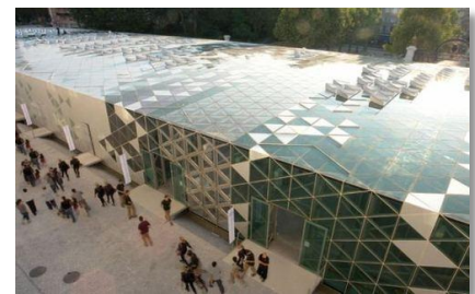
Figure 6: les panneaux solaires Source : www.panneaux solaire.com .
