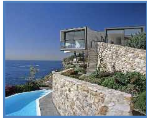
Fig 26: Maison en bord de mer Italie (grandes baies vitrées). Source : Mémoire fin d'étude
