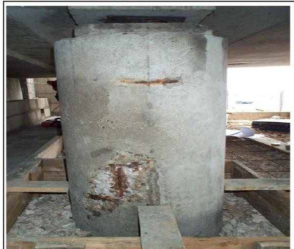
Figure1.5: Corrosion des armatures d'un pile de pont [6].
