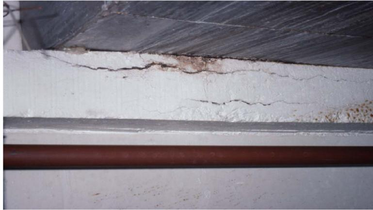
Figure 1.2: Eclatement du béton d'une poutre [6].
