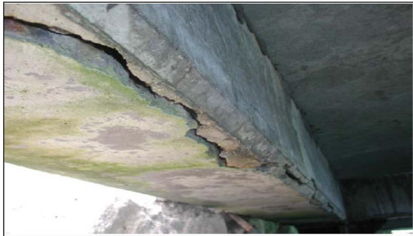
Figure 1.3: Poutre de tablier de pont dégradée [6].
