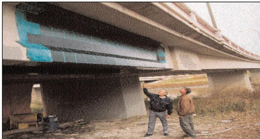
Figure 1.17 : Renforcement à l'aide de TFC [11].
