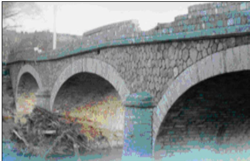
Figure1.1:Affouillement des rivières sur les ponts [6].
