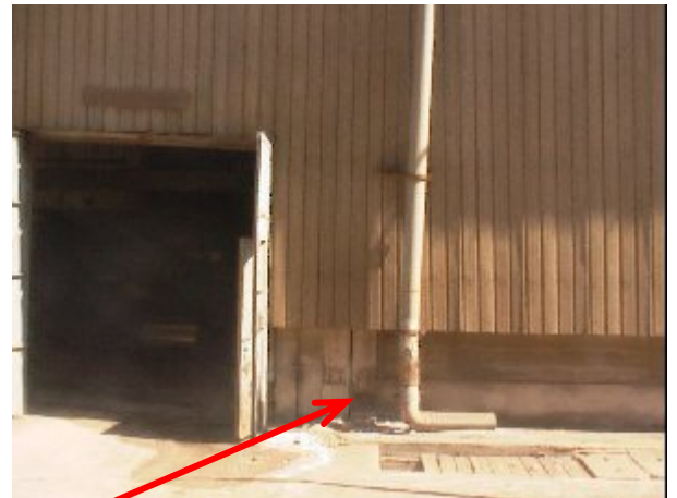
Figure 3.54 : joint sismique vu de l'extérieur.
