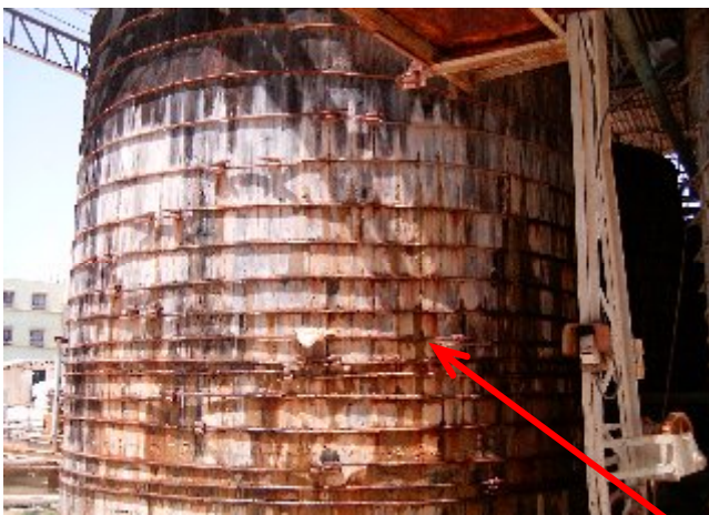
Figure 3.33: tirants de cuves de stockage : Corrosion très avancée avec dégradations.
