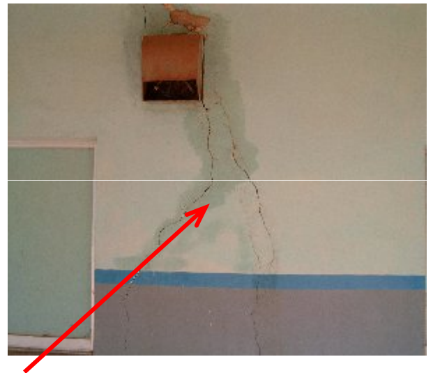
Figure 3.14 : Fissurations importantes dans les murs.
