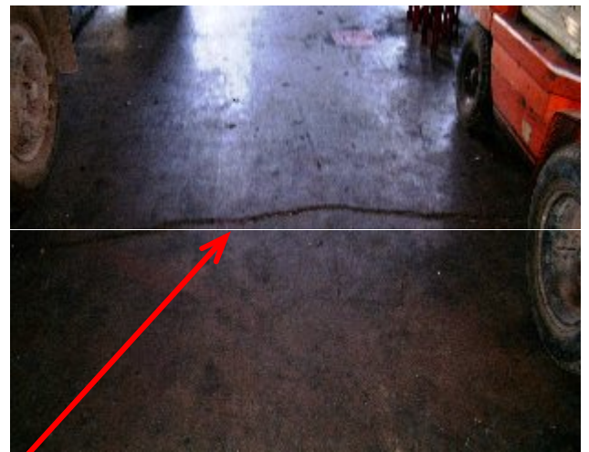
Figure 3.15 : Présence de fissurations dans les dallages.
