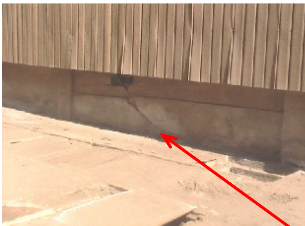
Figure 3.56 : Fissures à 45 degré à deux sens de par et d'autre du joint.
