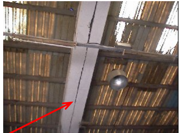
Figure 3.55 : Joint sismique vu de l'intérieur.
