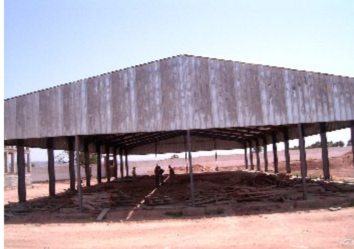
Figure 3.35 : Vue de l'extérieur de la structure.
