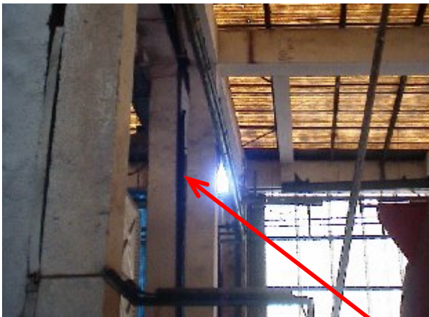
Figure 3.55 : Joint sismique vu de l'intérieur.
