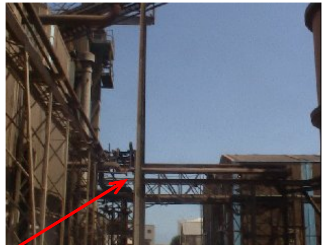
Figure 3.53 : Flambement des poteaux.
