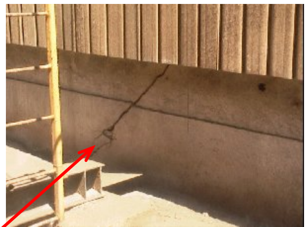
Figure 3.56 : Fissures à 45 degré à deux sens de par et d'autre du joint.
