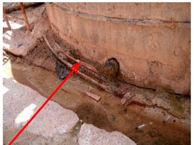
Figure 3.33: tirants de cuves de stockage : Corrosion très avancée avec dégradations.
