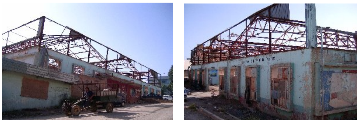
Figure 3.41 : Marché : vu de l'extérieur.
