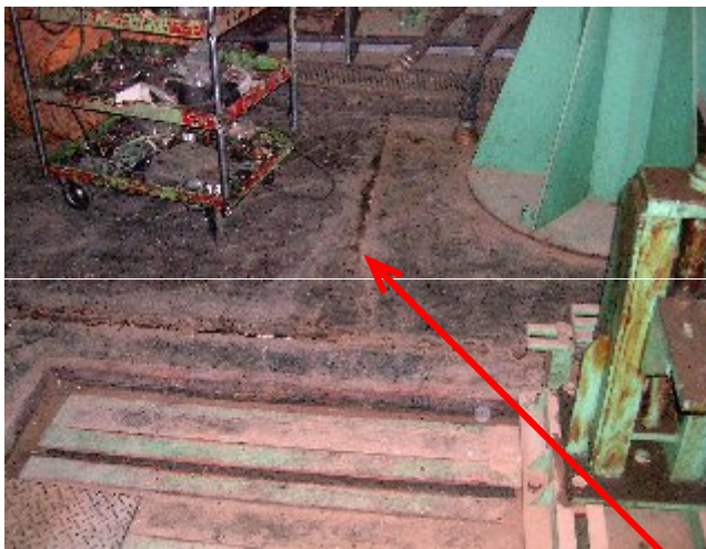
Figure 3.15 : Présence de fissurations dans les dallages.
