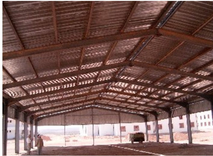
Figure 3.36 : Vue de l'intérieur de la structure.
