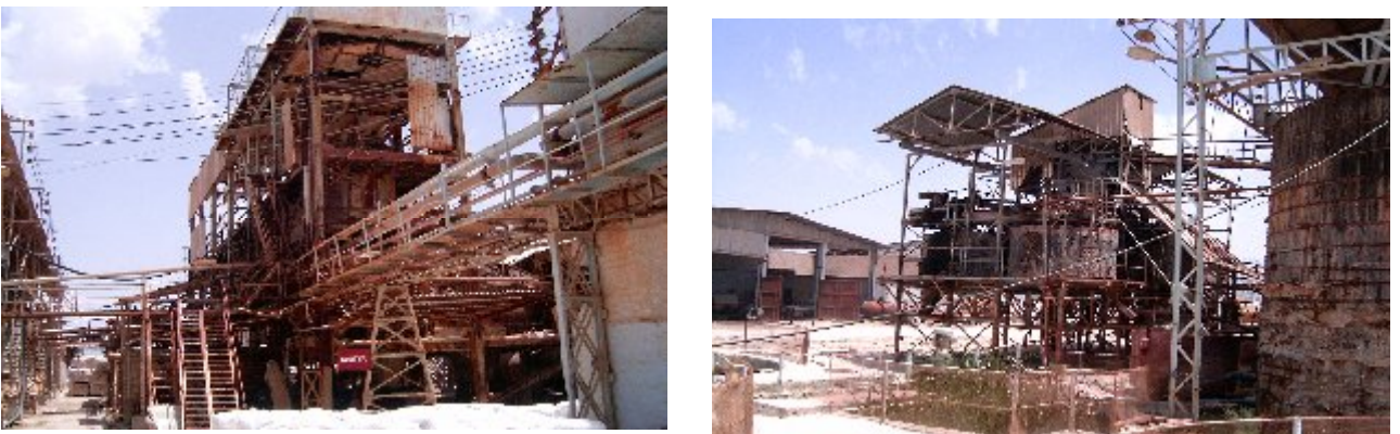
Figure 3.24 : Les extensions : vue de l'extérieur
