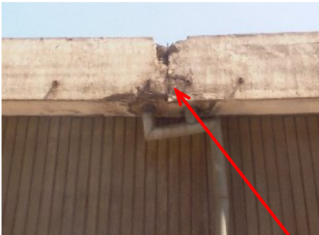
Figure 3.54 : joint sismique vu de l'extérieur.
