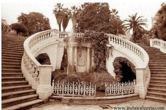
Fig. 82 Ancienne vue de l'entrée du bas
