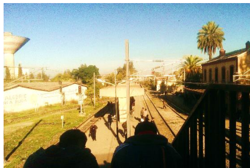
Fig. 24 La gare ferroviaire Beni Mered, Blida
